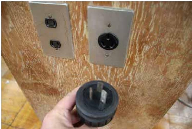
物理の実験室の生徒机には、左の写真のようなコンセントがある。教師用の実験机もよく探してみると、同じコンセントがある。これらはつながっていて、教師用の机から生徒用の机に音波が送れるようになっている。低周波発信器があれば、すべての生徒用机に一斉に音波を送ることができる。メルデの実験でスピーカーを波源に使う場合や、クインケ管で音速をはかるときに便利である。
