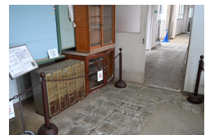
4階・浸水の高さがわかる
