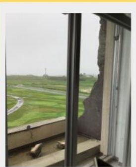
↓内側から見た外壁
