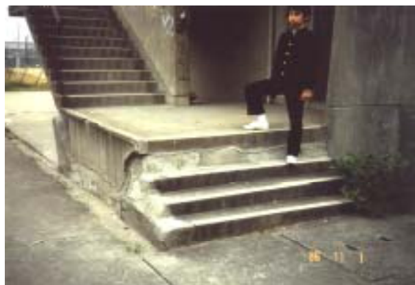
写真 8 ( 24-p8 ) 校舎の地盤沈下・抜け上がり現象 ( 大阪市・生野区 )
