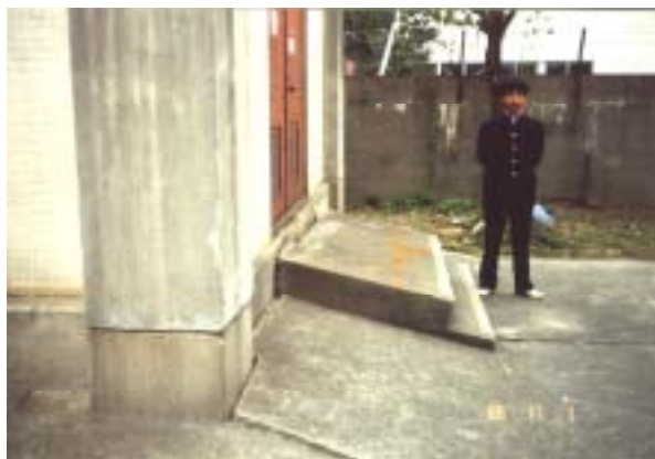
写真 8 ( 24-p8 ) 校舎の地盤沈下・抜け上がり現象 ( 大阪市・生野区 )
