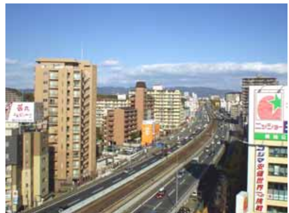
図2 北大阪急行御堂筋線 江坂駅から桃山台駅の間地点から北方を望む
