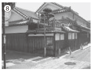
⑧田守家 屋号を「黒山屋」とし、木綿屋を営ん でいました。18世紀前半の建物と見られ、 旧杉山家に次ぐ古い年代のものです。
