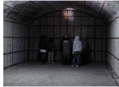
旧陸軍弾薬庫跡の内部
