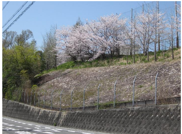
敷地南側道路から
