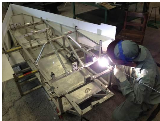
サスペンション部品を溶接している様子
