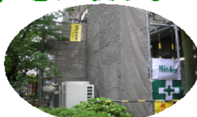
空調室外機の補修工事(中庭)、少し見にくいですが、
