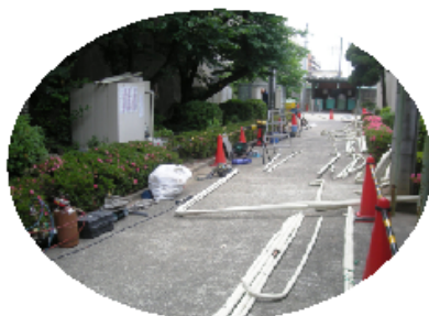
空調室外機の移設工事(中庭)。少し見にくいですが、
