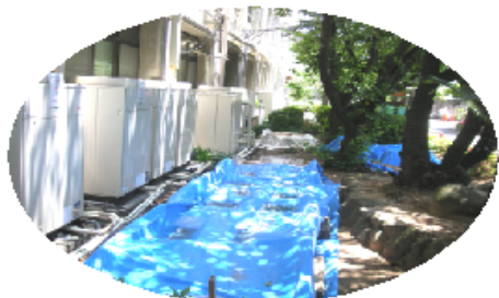
空調室外機の移設工事(中庭)、少し見にくいですが。
