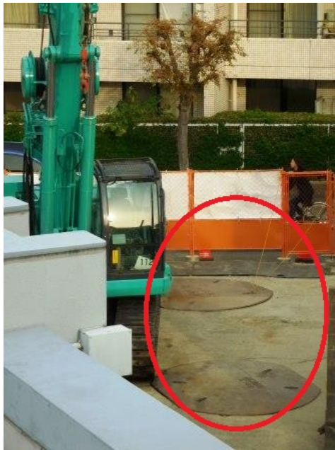
<赤丸印の地下に大きな貯水槽が埋設されています>
