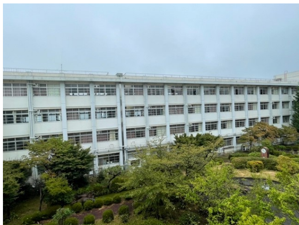
職員室から見た一般教室棟
