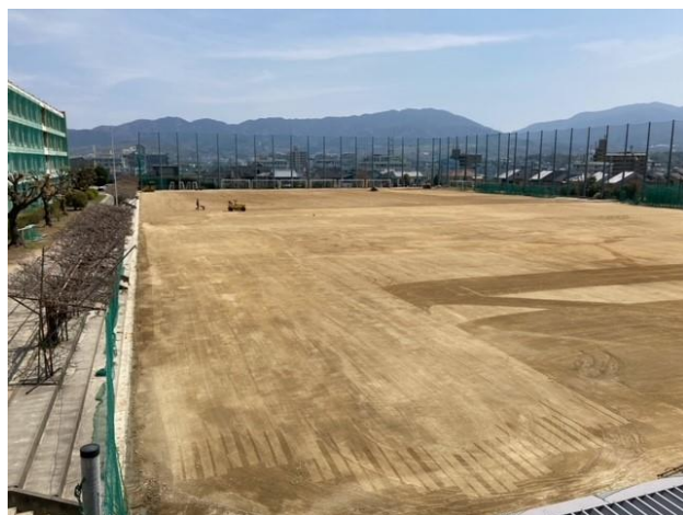
完成間近のグラウンド
