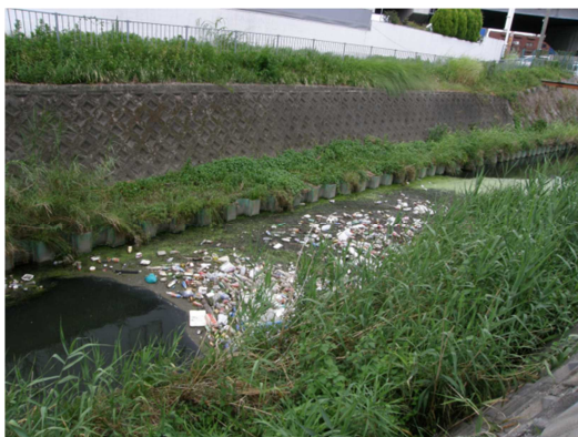
地点4 八尾市・大阪市境界付近
