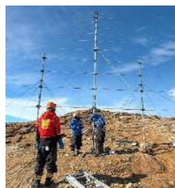
アンテナ点検中
