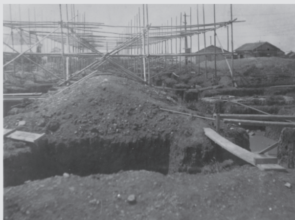
本館の建築足場
