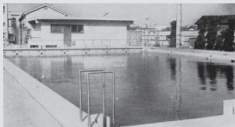
施工したプール
