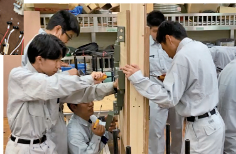
電気工事实習
