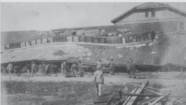
室戸台風で崩れた校舎
