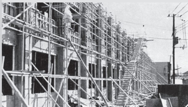
実験棟建設中
