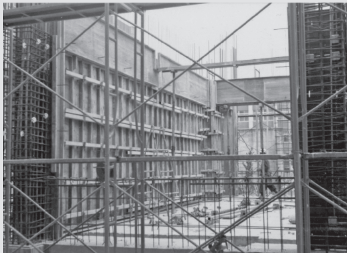
工事中の電気科棟
